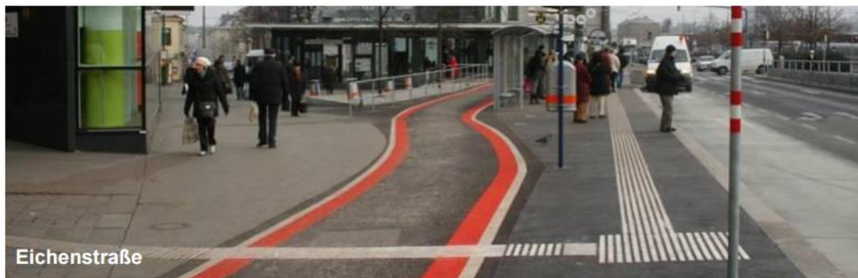
Przed i po przystosowaniu do potrzeb niewidomych - ul. Eichenstrasse we Wiedniu, fot. OBB Stadt Wien
